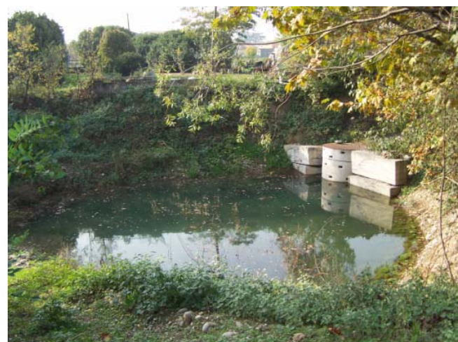
Testa con tino in cemento con aperture e coperchio (foto Arzuffi).
