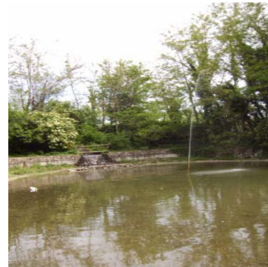
Tubo in metallo per favorire la fuoriuscita dell'acqua e muro di contenimento in borlanti e cemento nel capofonte (foto Beretta).
